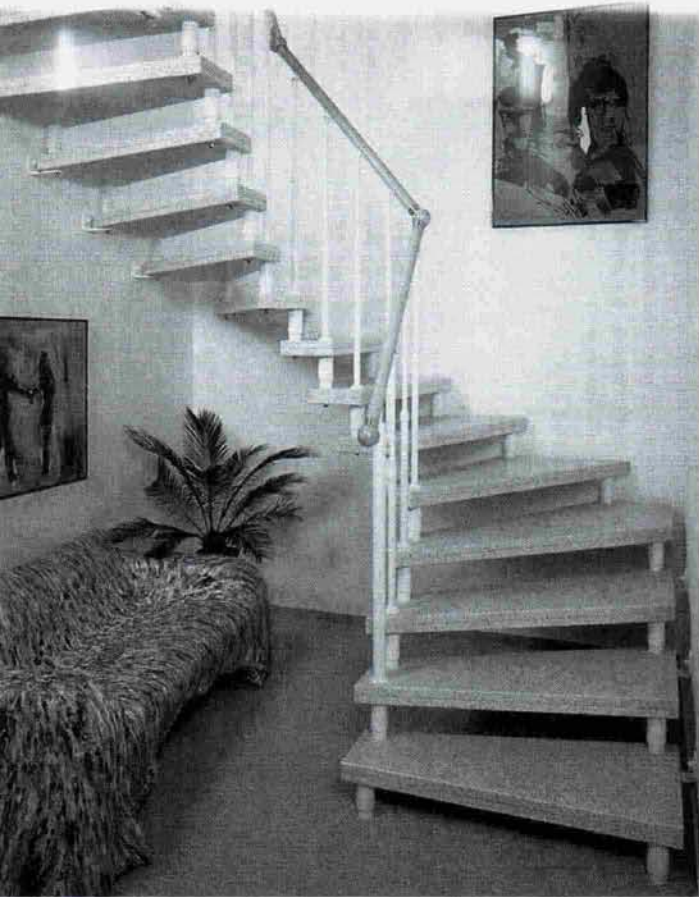
Лестница с предварительно изготовленными сборными ступенями из искусственного камня, прикрепленными к стене и ограждению
