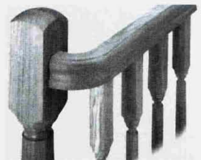
Рис. 8-37. Насадка пластмассового тянутого профиля на профилированную металлическую конструкцию.
