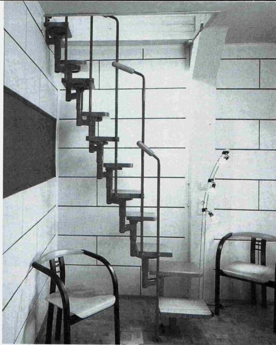
Компактная лестница «гусиный шаг» с цепным устройством несущей хребтовой конструкции и ограждения
