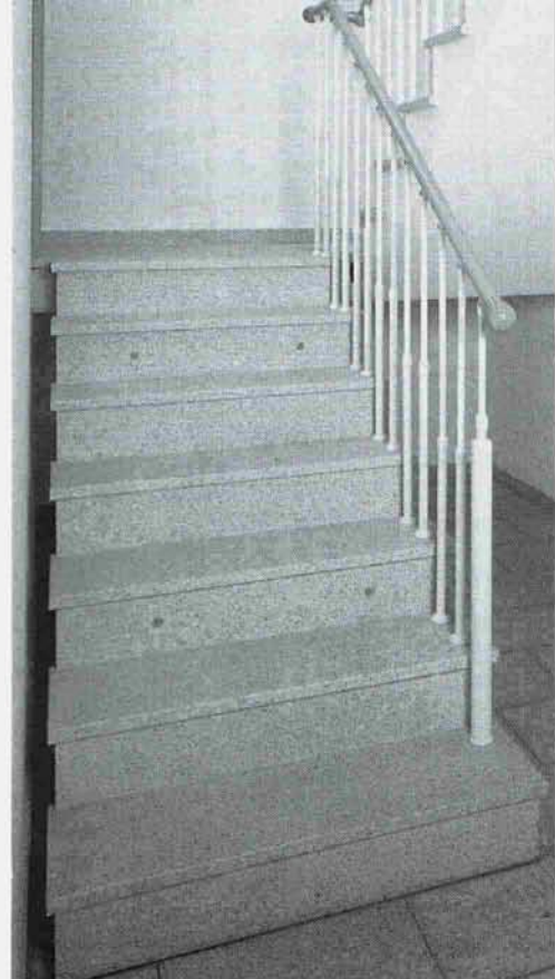
Прямолинейная монолитная железобетонная лестница со ступенями из искусственного камня и телескопическим ограждением
