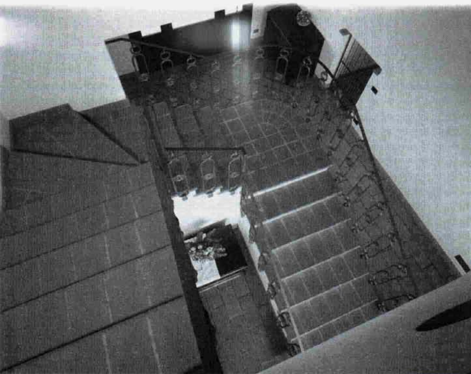
Двухмаршевая лестница с лестничной площадкой и встроенными забежными ступенями
