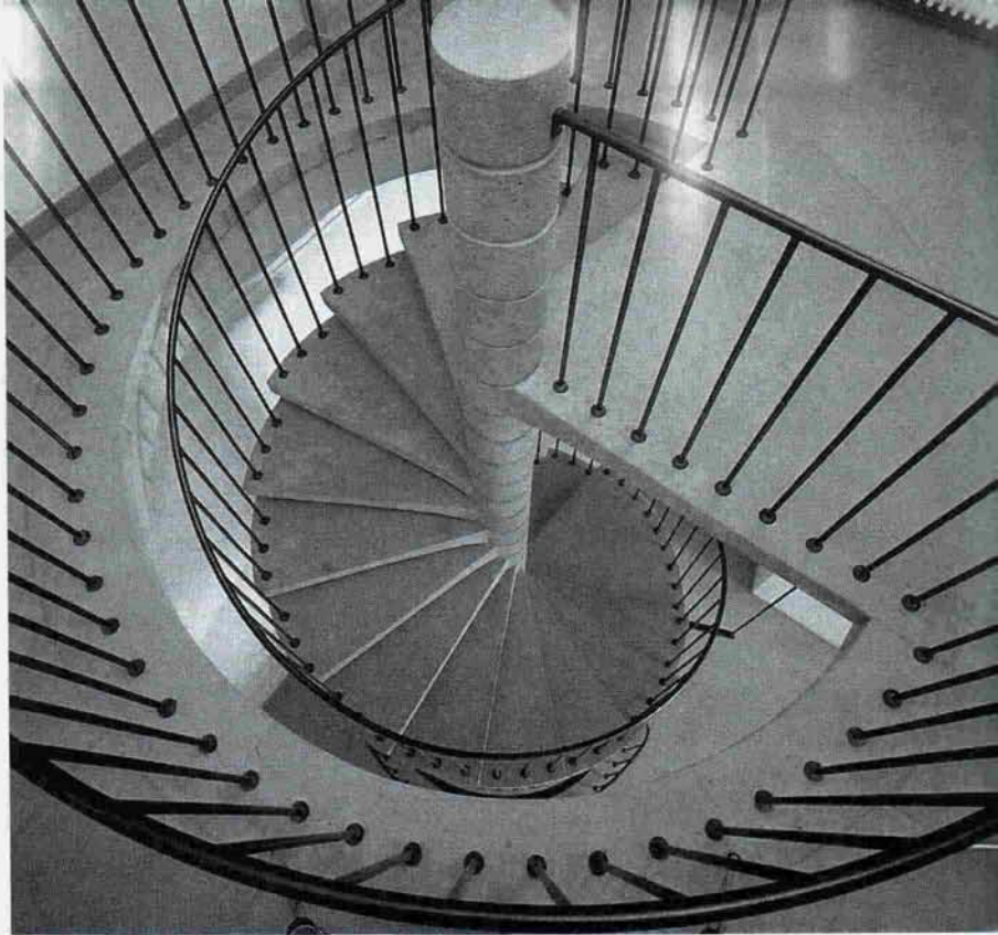
Вид сверху на сборную железобетонную лестницу с верхней лестничной площадкой на четверть круга
