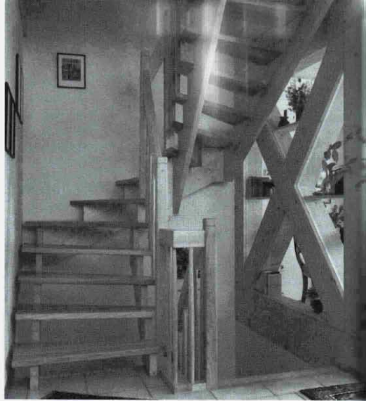
Одномаршевая деревянная лестница с клиновидными ступенями при повороте на 1/2 и нижним закреплением на две опорные деревянные балки
