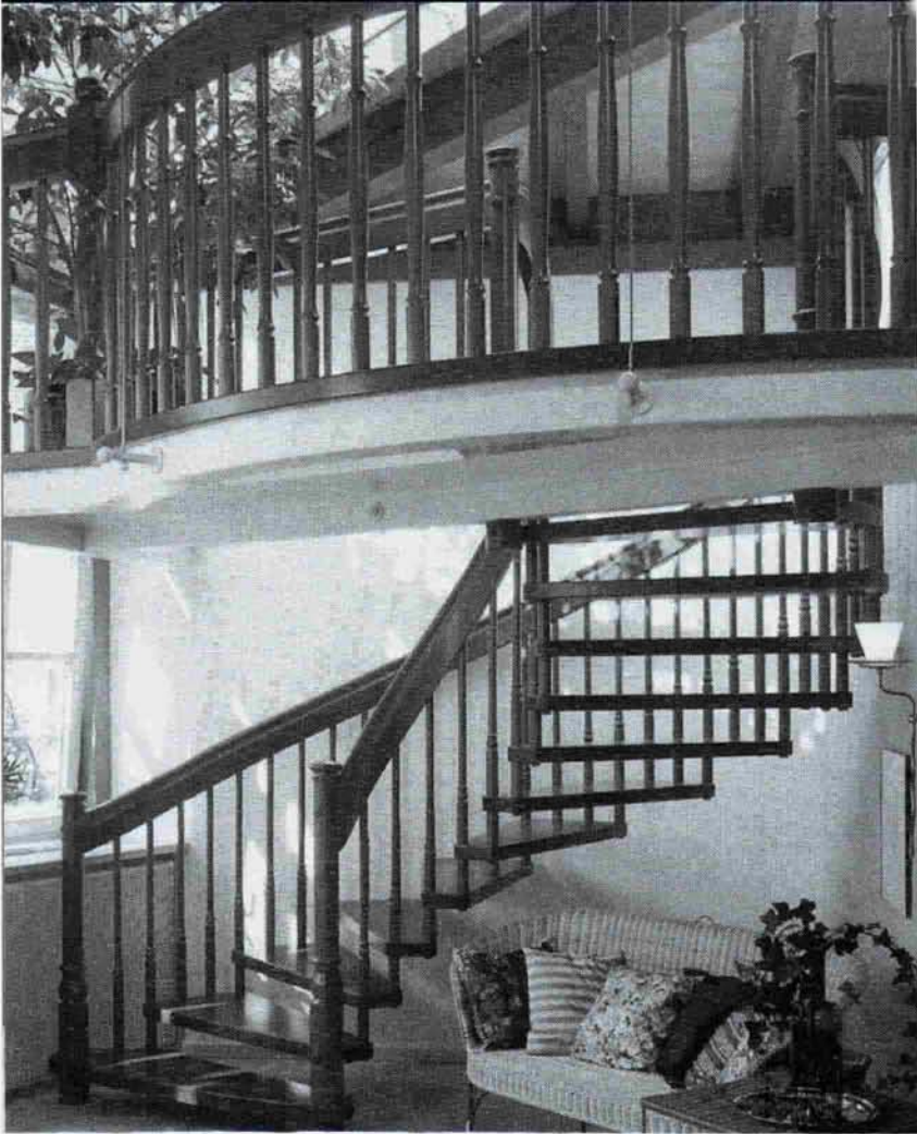
Внутренняя лестница с опорным ограждением и деревянными ступенями, прикрепленными к деревянному каркасу ограждения
