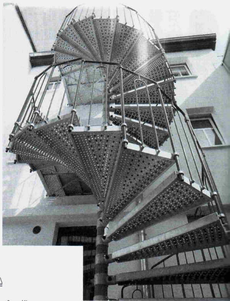
Спасательная эвакуационная лестница на внутреннем дворовом фасаде здания. Материал лестницы — оцинкованная сталь, ограждение покрашено методом напыления
