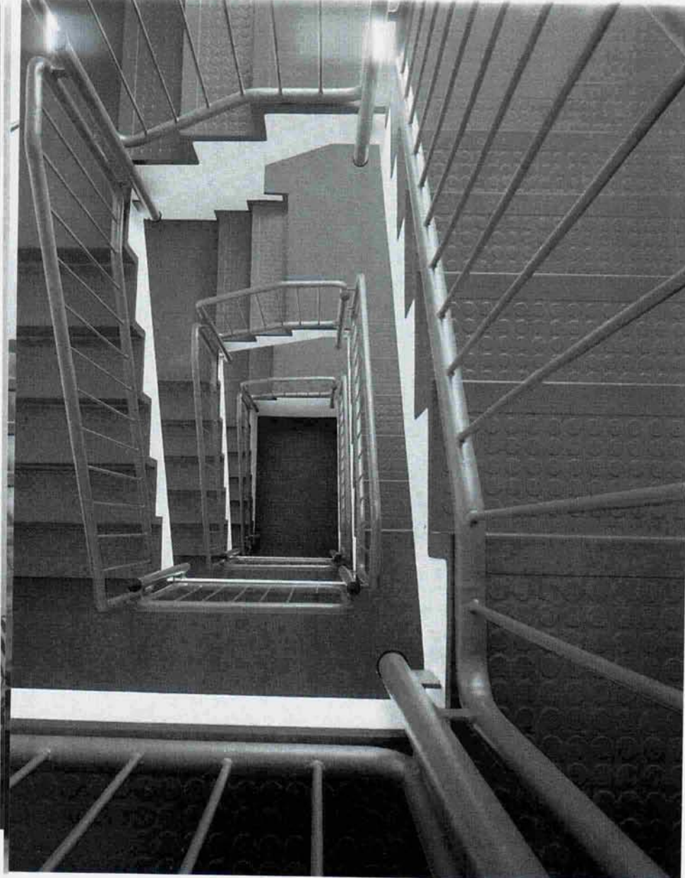
Ступени и лестничные площадки в подьезде общественного здания, покрытые резиновыми пластинами
