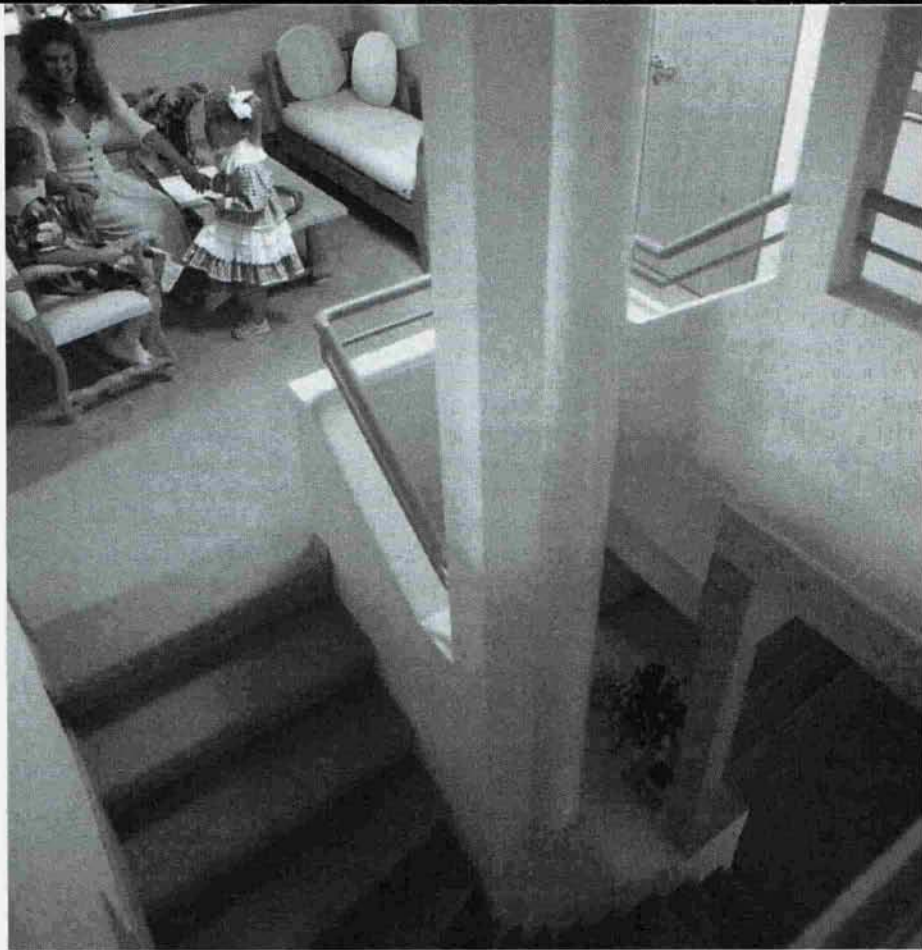
Рис. 2-10. Лестница «гусиный шаг» со ступенями полной ширины, расположенными перпендикулярно ходовой полосе
