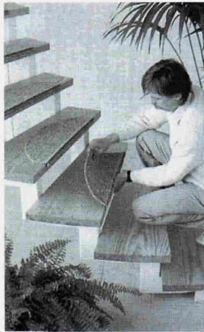
Прикрепление самоклеящихся элементов коврового покрытия к ходовой поверхности лестницы
