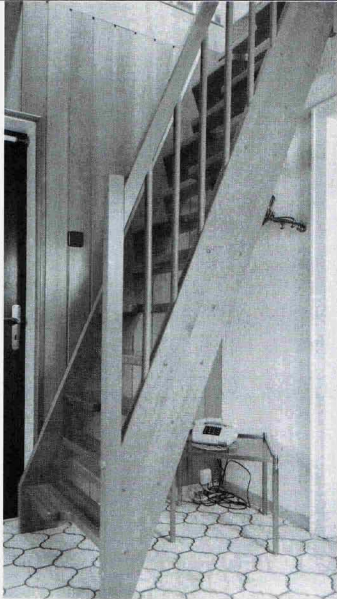
Компактная лестница «гусиный шаг» в углу комнаты
