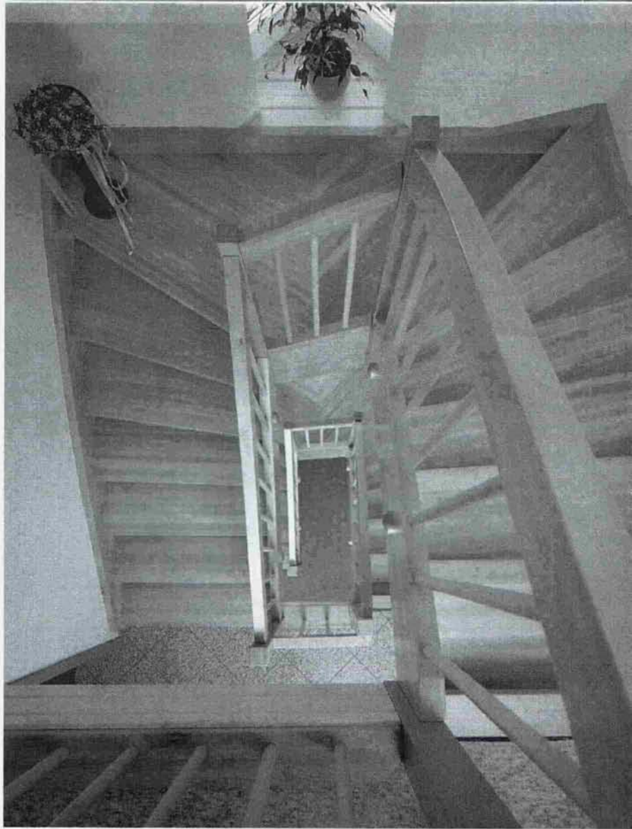
Двухмаршевая деревянная лестница с клиновидными, закрепленными в тетиву ступенями. Вид сверху
