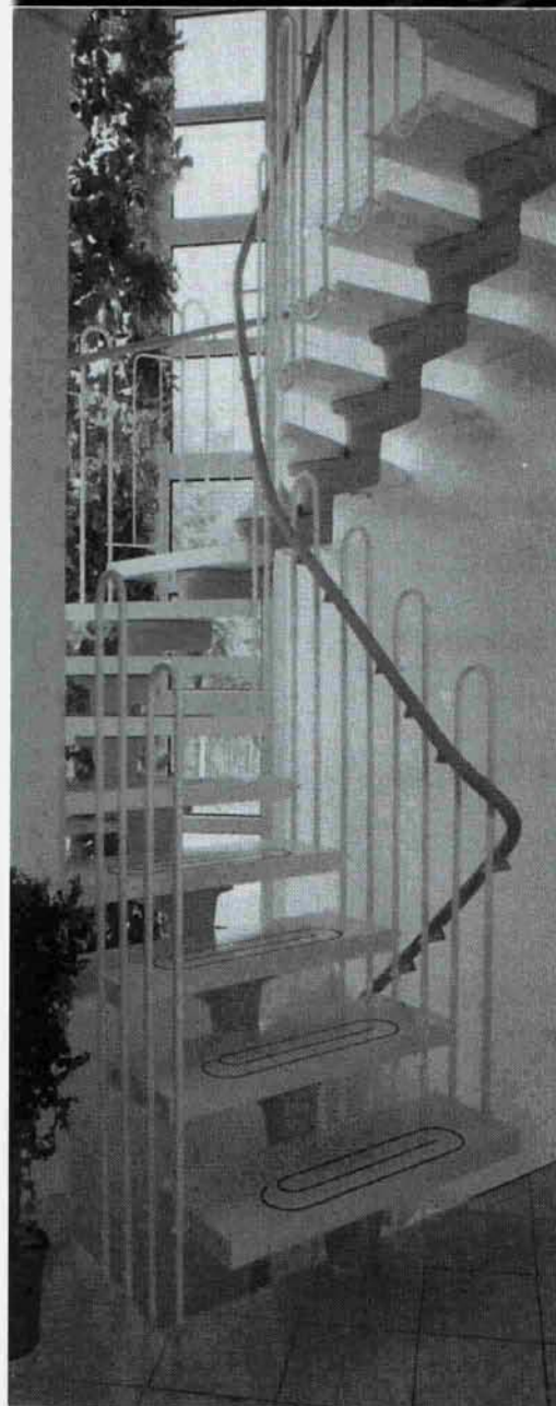
Цепная лестница внутри жилого дома с ограждением в виде шпильки и поперечным полым, стержневым поручнем
