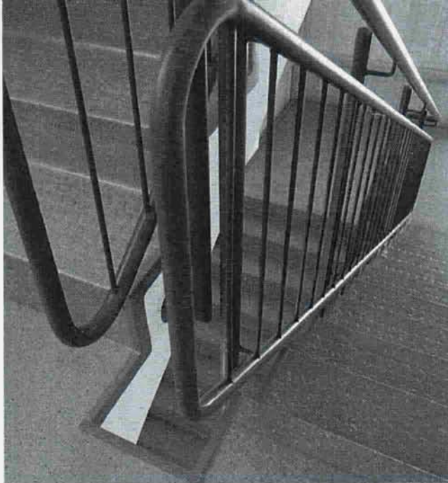
Предварительно изготовленные плоские ограждения, прикрепленные к несущим столбам
