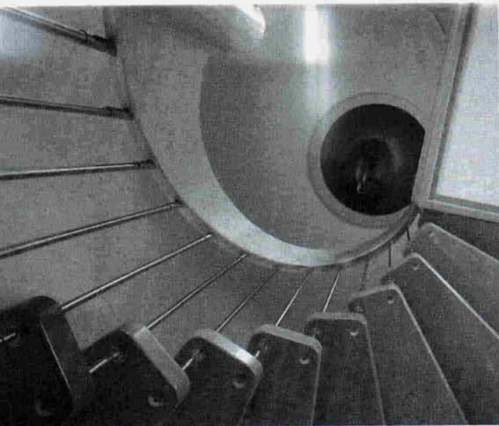
Вид снизу на круговую лестницу с ограждением, укрепленным вдоль лестничного проема
