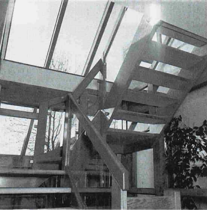
Трехмаршевая лестница с параллельным ведением маршей, деревянной тетивой и сплошным барьером из органического стекла
