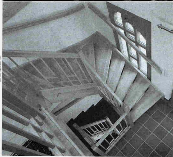
Деревянная лестница с клиновидными забежными ступенями, крепящимися к тетиве
