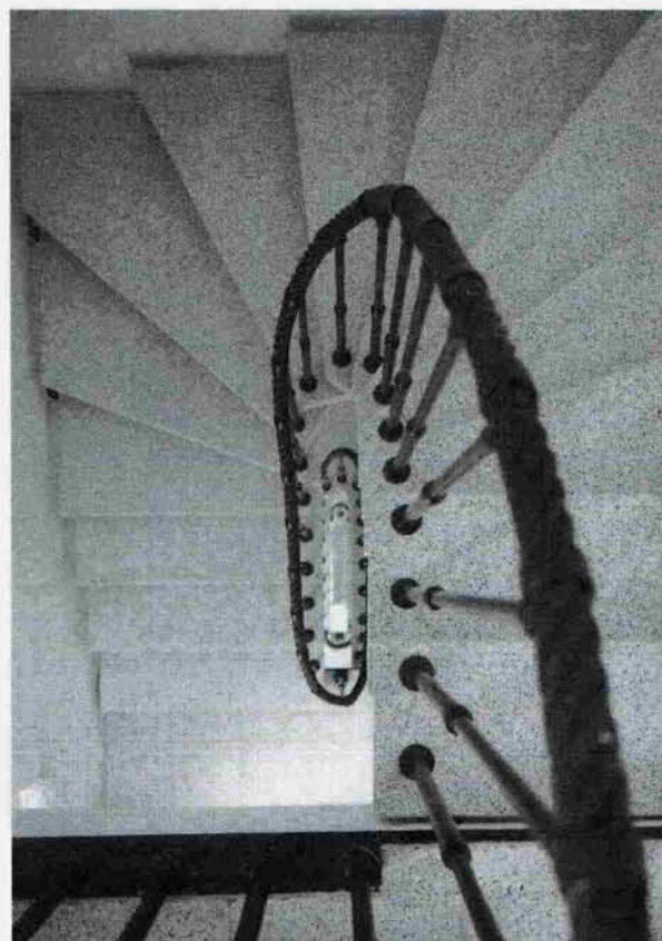
Лестница с цепным соединением ступеней. Вид сверху позволяет увидеть, насколько лучеобразное расположение ступеней облегчает движение на повороте
