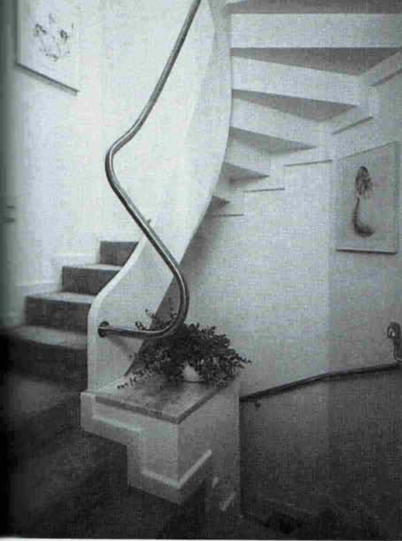
Дугообразная деревянная лестница с многослойной конструкцией ступеней, прикрепленных к стене и тетиве
