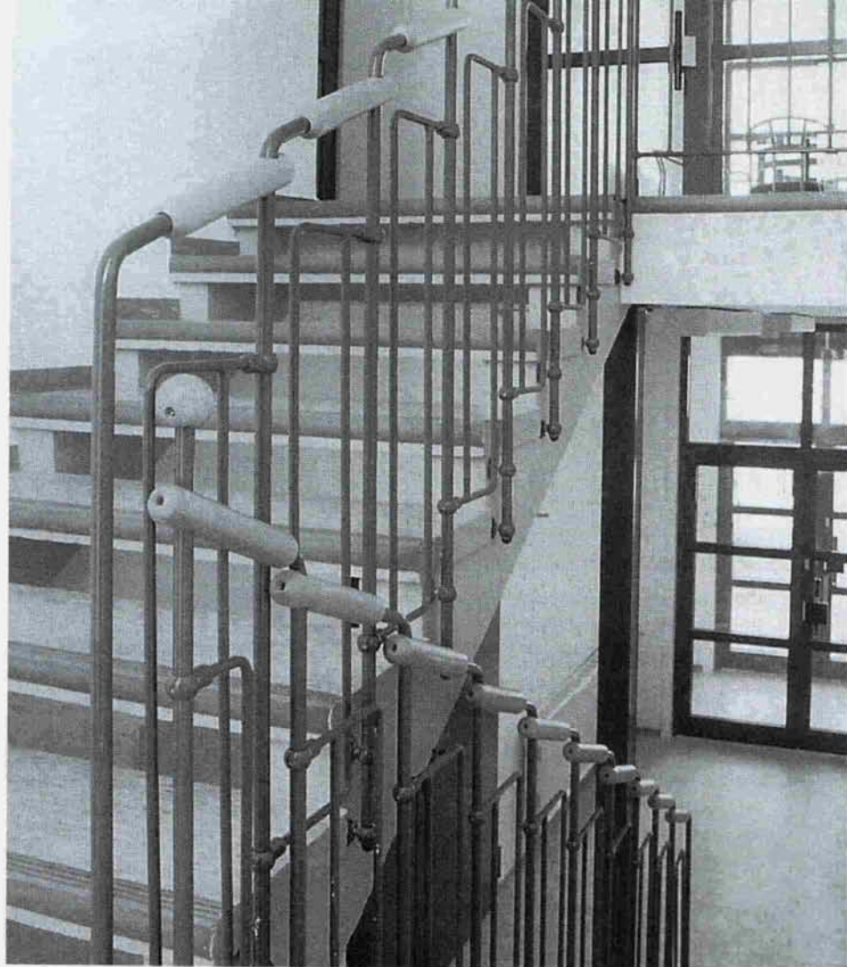
Универсальное ограждение крупно лестницы общественного здания, прикрепленное шпильками
