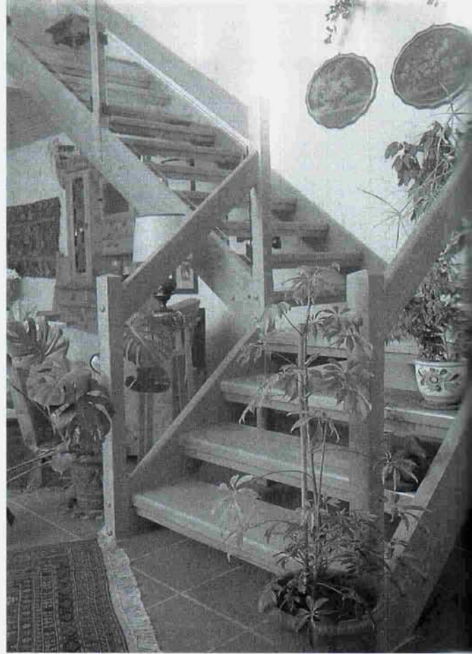
Двухмаршевая деревянная лестница с промежуточной площадкой и опорным столбом
