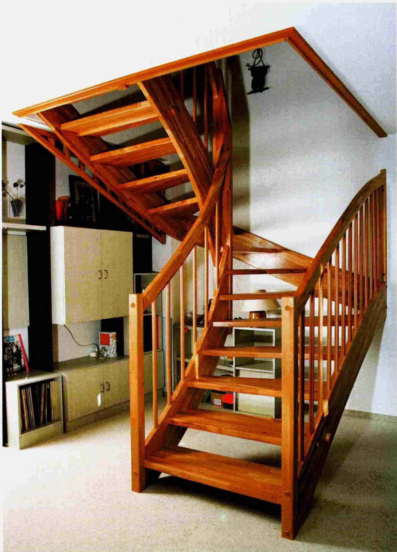
Криволинейная деревянная лестница с клиновидными ступенями на повороте. Слоеная деревянная тетива, несущая на себе лестничную нагрузку, представляет собой чрезвычайно изящную конструкцию и одновременно гарантирует надежность и прочность всего сооружения
