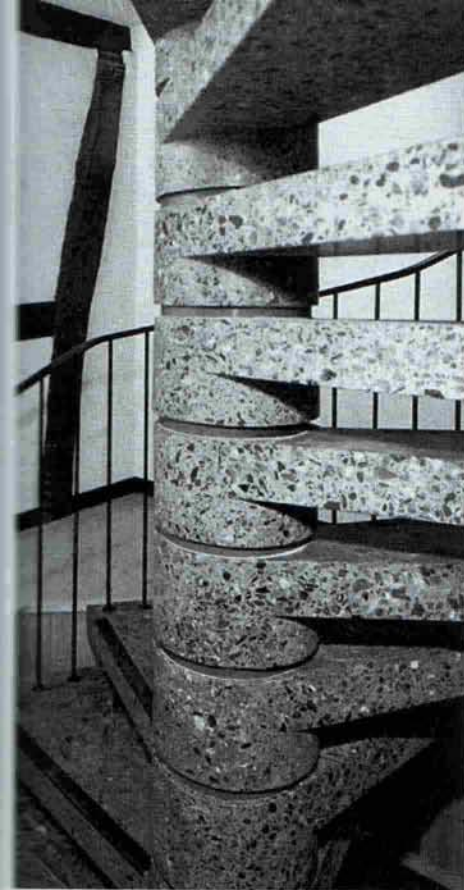
Сборная винтовая подвальная лестница внутри дома со ступенями из искусственного камня
