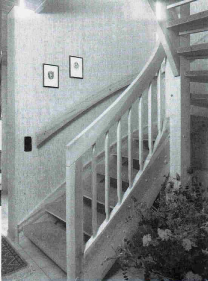
Одномаршевая, с поворотом на 1/2 деревянная лестница с клиновидными ступенями с ковровым покрытием
