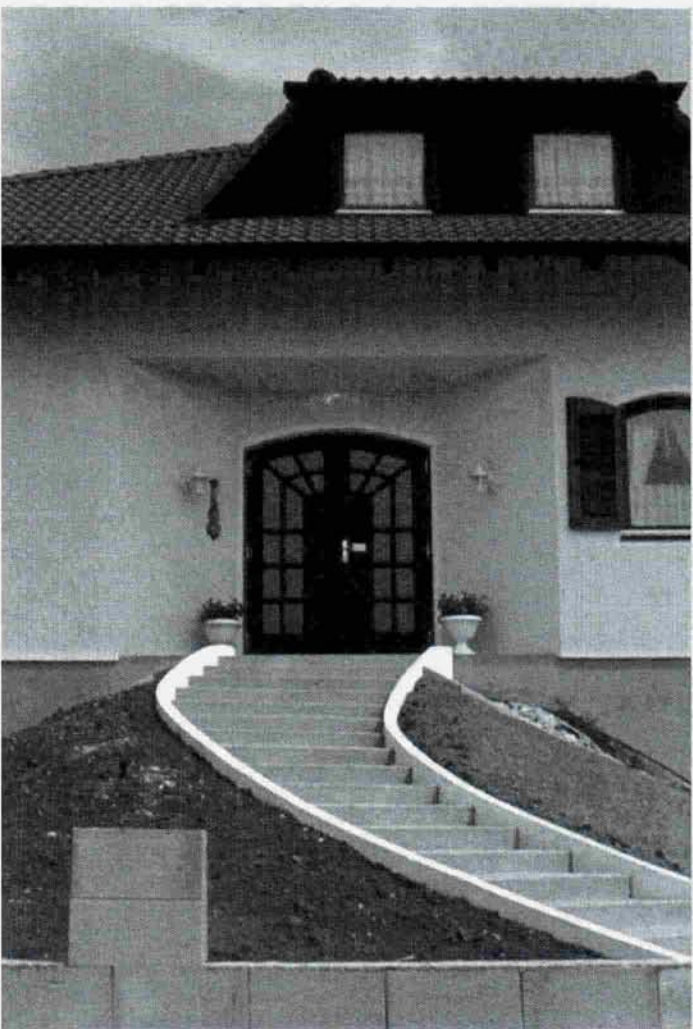
Рис. 10-4. Наружная крыльчатая лестница, собранная из готовых элементов а) горизонтальная проекция; б) фрагмент укладки фундамента; 1 элемент ступени с угловым поворотом; 2 прямые элементы ступеней; 3 облицованная лестничная площадка; 4 стык соединения; 5 боковые элементы фундамента для опоры ступеней; 6 промежуточные элементы фундамента ступенчатой формы; 7 основной массив фундамента; 8 ленточный фундамент; 9 уширение фундамента здания; 10 заполнение гравием; 11 вазон для цветов; 12 поддон; 13 отверстие для стока; 14 открытая поверхность бетонная (промытый гравий).
