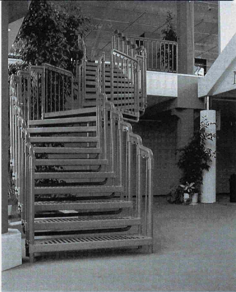
Внутренняя лестница с несущим опорным ограждением и стальными ступенями с резиновым покрытием
