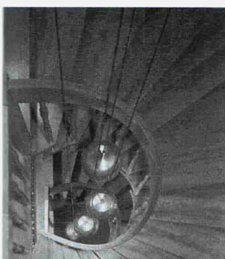
Рис. 1–15. Изогнутые межлестничные проемы a) в форме круга; б) оригинальной формы; 1 межлестничные проемы; 2 лифт; 3 лестничные марши; 4 лестничная площадка.
